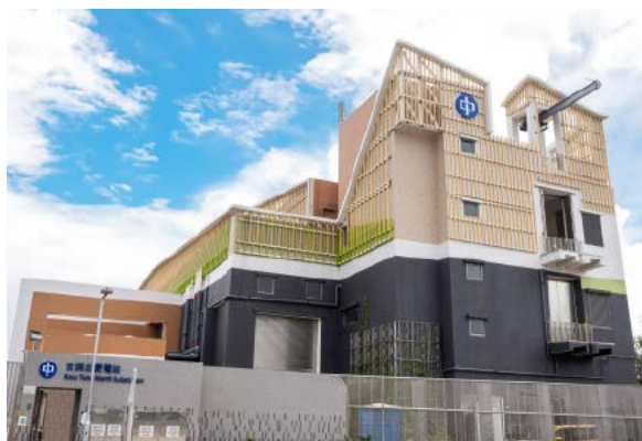
古洞北變電站
