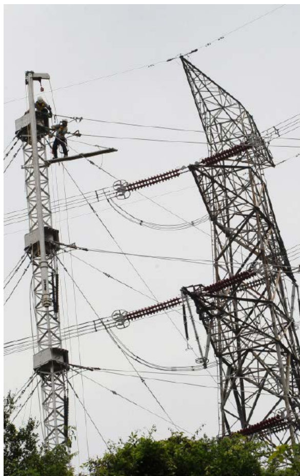
架空電纜技術人員正在約 70 呎高的臨時電塔上接駁導線。建造一個臨時電塔需時十多天，較重建傳統輸電塔快十多倍
