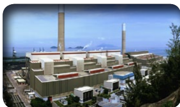
青山發電廠的低氮燃燒器
