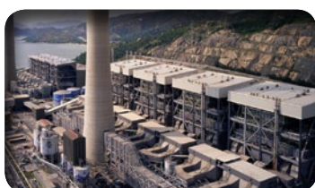
青山發電廠的脫硫除氮設施
