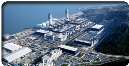
採用天然氣發電的龍鼓灘發電廠
