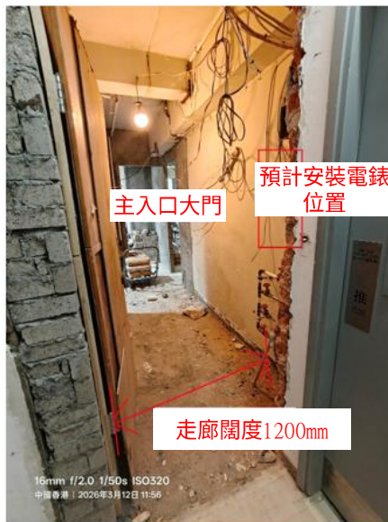
預計安裝電錶板的位置
