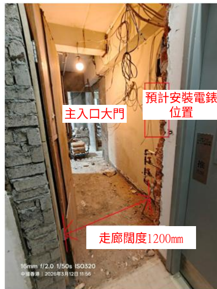
預計安裝電錶板的位置
